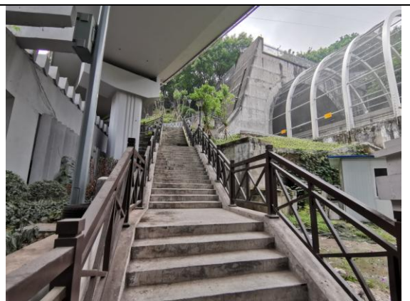
隧道入口下方边坡人行步道及绿化
