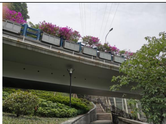
隧道入口桥下绿化及人行步道
