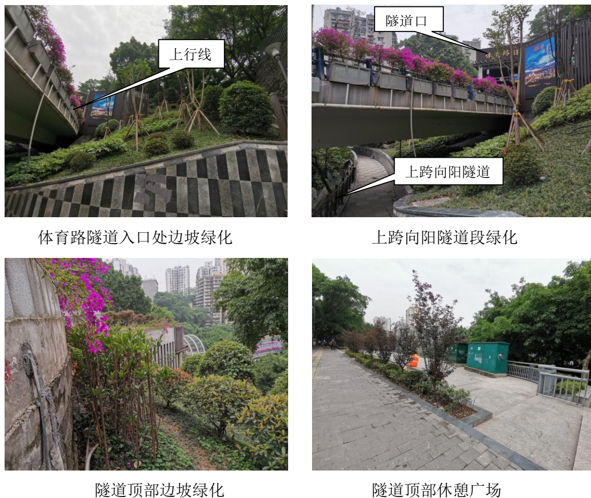
图 5.1 隧道入口边坡防护生态恢复实景
