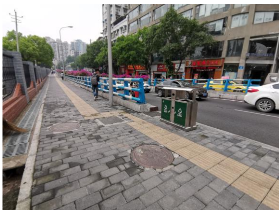
隧道出口桩号 K0+800 处右侧
