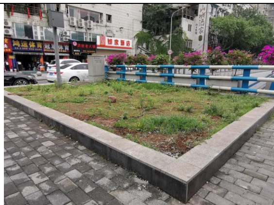
隧道出口顶部草坪绿化
