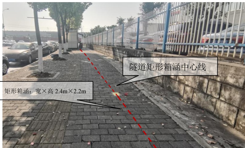
暗挖段（K1+338~K1+994.09 段）实景
