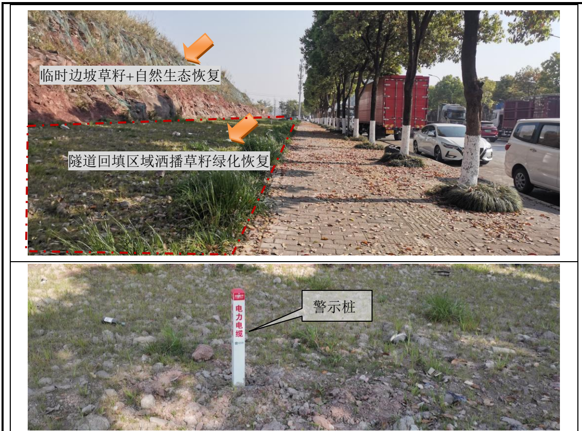
图 4.1 明挖段二生态恢复措施及实景
