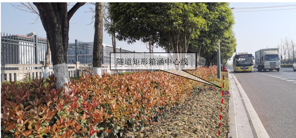
暗挖段（K0+642~K1+338 段）实景
