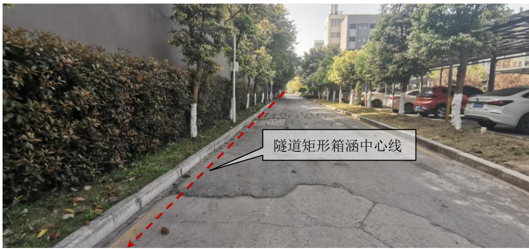
顶管段（K0+000~K0+239.55 段）地面实景
