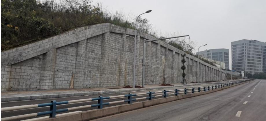
图 7.3 道路 K0+652.15~K0+773.65 段右侧桩板挡墙护坡
