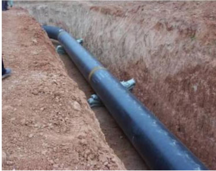
图 3.1-3 一般地段施工现场图
