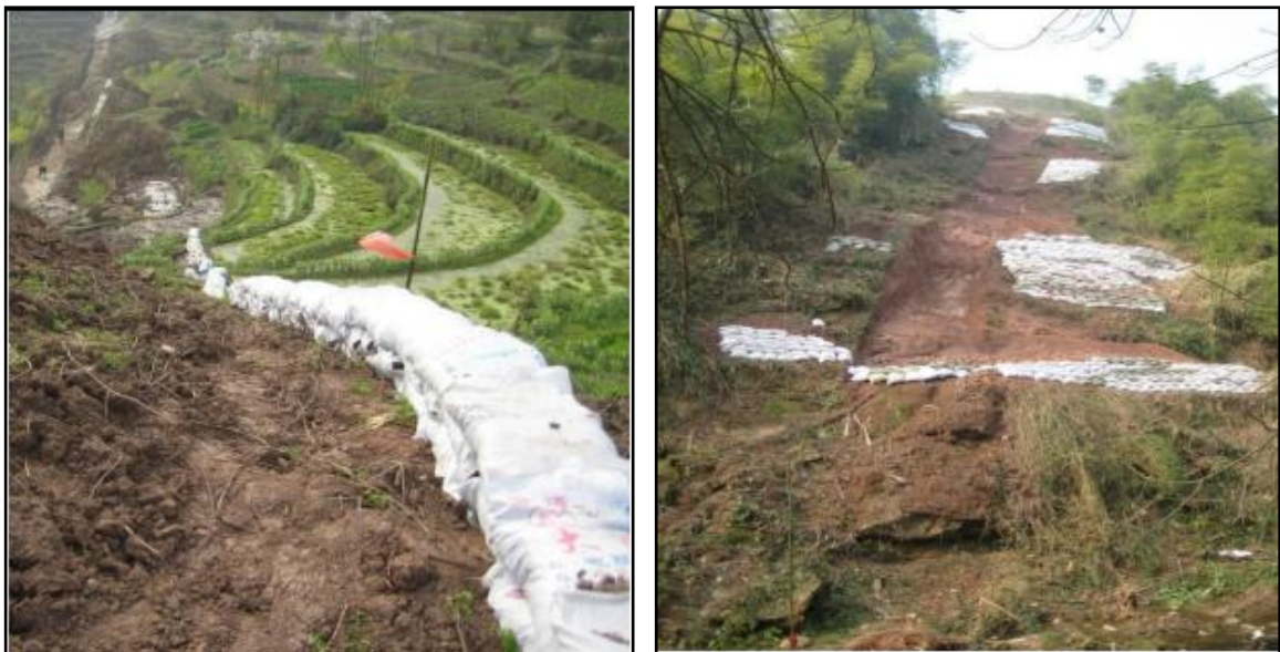
图 3.1-4 施工作业带典型临时水工保护措施示意图
