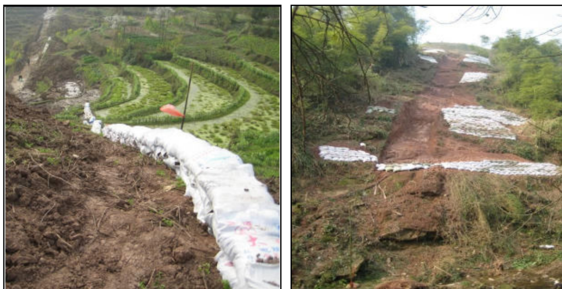
图 3.1-4 施工作业带典型临时水工保护措施示意图
