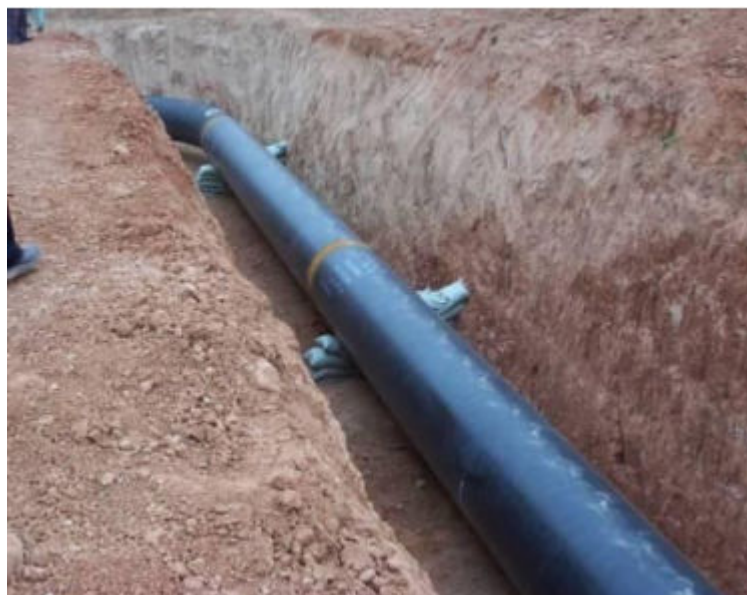
图 3.1-3 一般地段施工现场图
