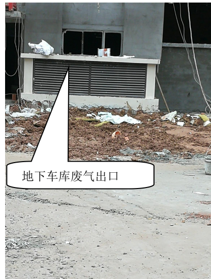
车库风井出口
